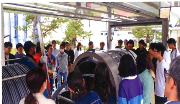
SPR工法製管デモ施工(苫小牧高専)
